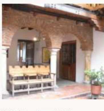
Patio, Casa Manuela Sáenz.
